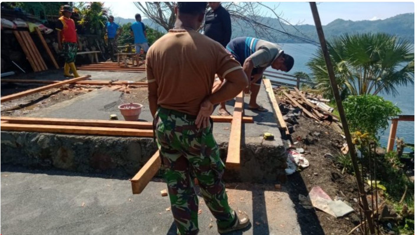
Satgas TMMMD Ke 16, pada Pekerjaan RTLH Warga Kelurahan Tandurusa
