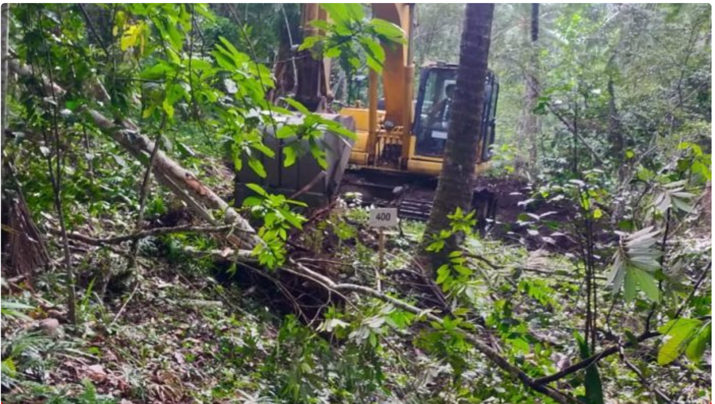
Pekerjaan akses Jalan TMMD Ke-116
